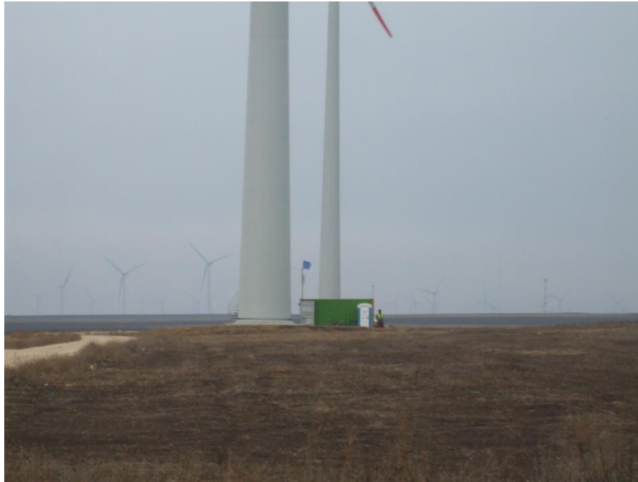
Foto 1. Container pentru paznici, grup sanitar ecologic si container pentru deseuri menajere
