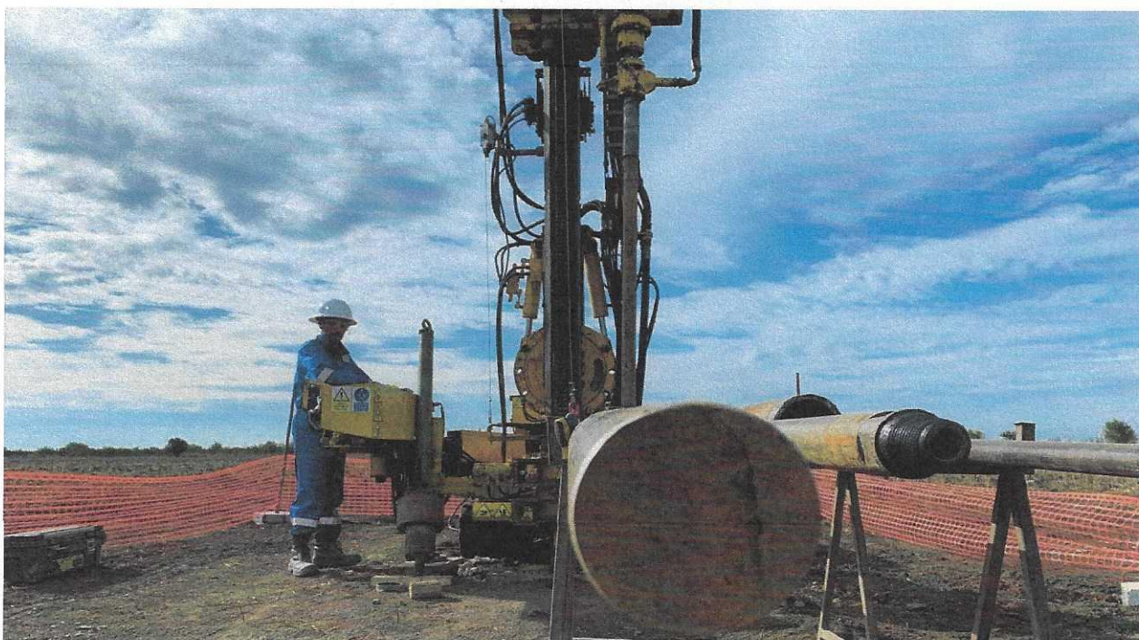
Figura 13. Instalația de foraj Beretta T46, prelevare de probe netulburate în formațiunea de loess (Shelby 101.6mm)
