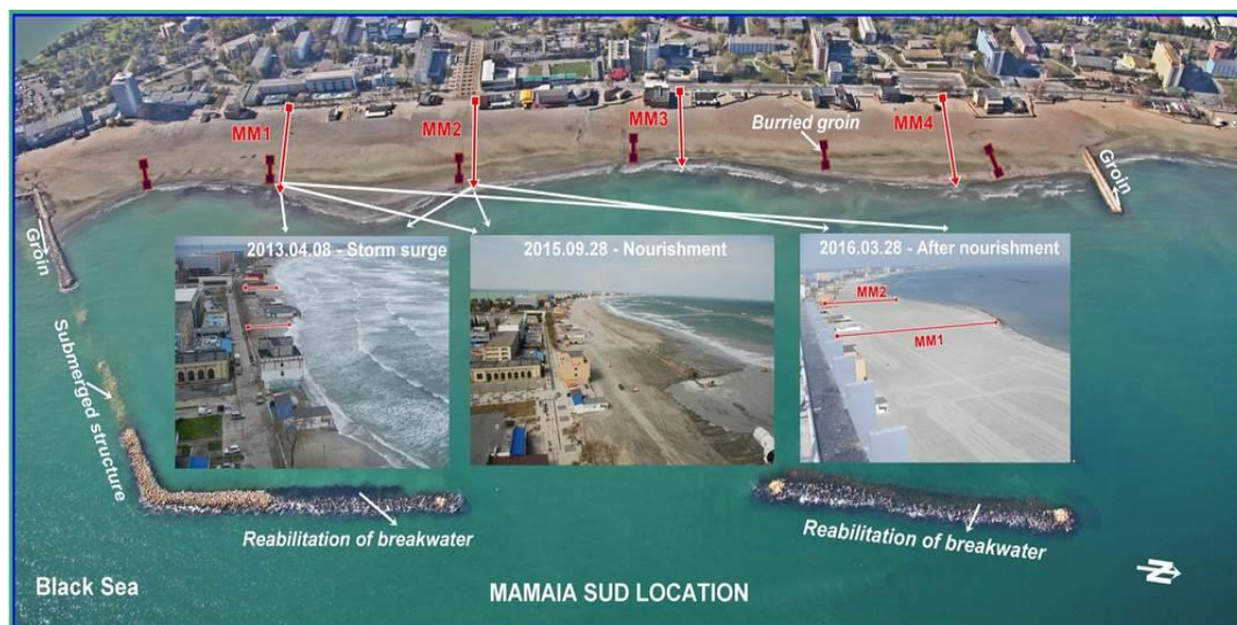
Fig. II.3.4.2.5. Lucrări pentru protecția costieră și extinderea plajei (sectorul Mamaia)
