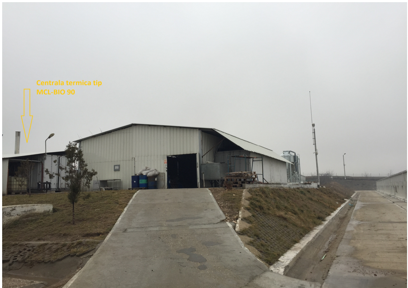
Amplasamentul centralei termice ce deserveste hala nr.3
