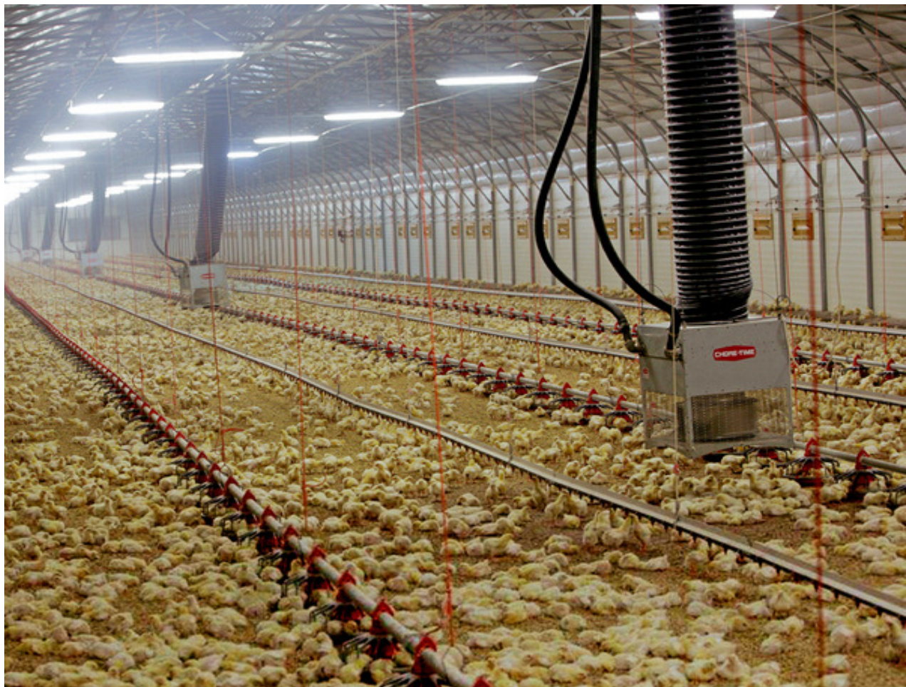
Sistem de incalzire cu termoconvector TOBO (hala 1)
