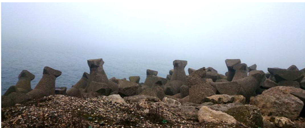
Fig.4 Zone descoperite, datorita alunecarii stabilopozilor, Dig de Larg Port Constanta ( foto : D.Craciun.)
