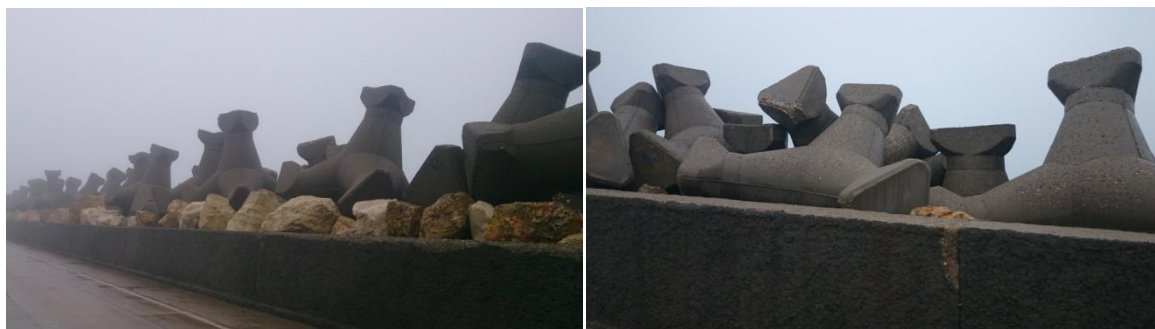
Fig.2 Tronson cu stabilopozi alunecati , Dig de larg Port Constanta ( foto: D.Craciun)
