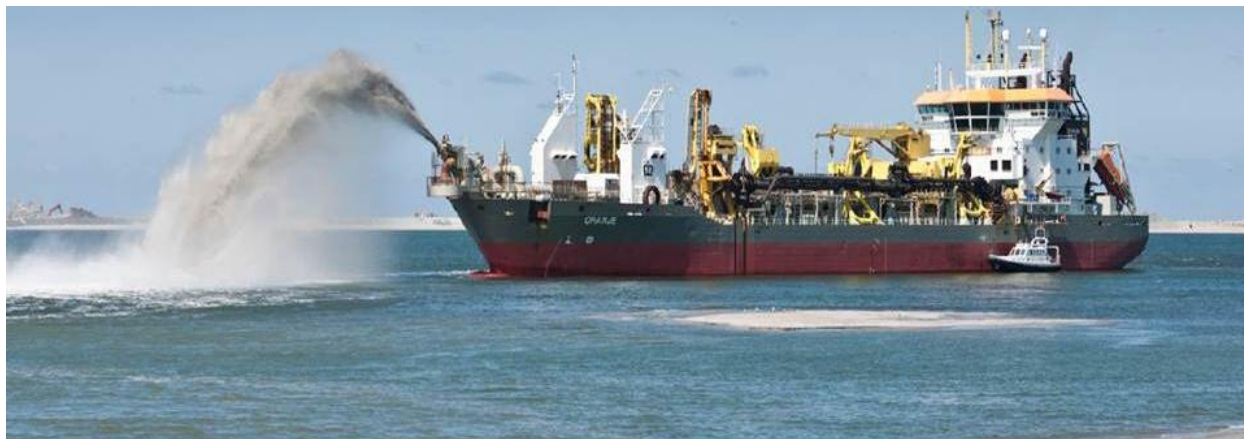
Fig. 2.16 – Pompare la tarm prin metoda rainbow (www.boskalis.com)
