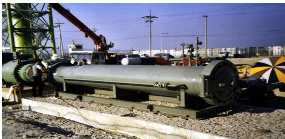
Figura 2 Recepția parafinei în gara de godevil sosire
