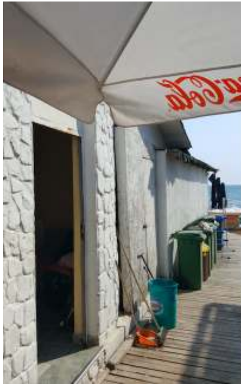
Foto cladire (latura de sud)
