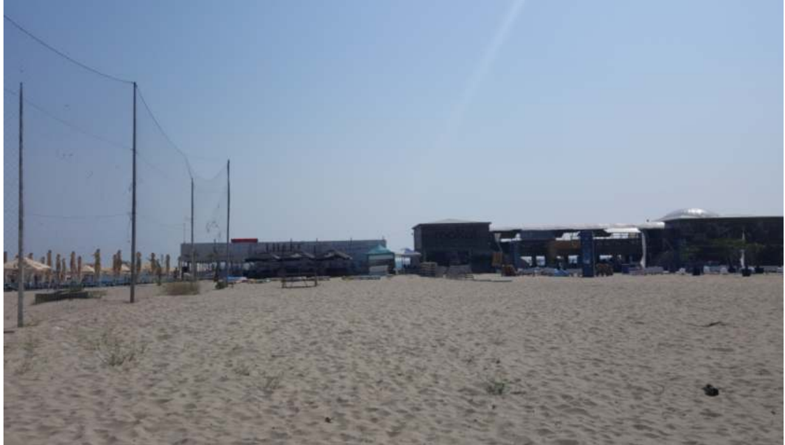
Foto: Privire de ansamblu asupra zonei in care se afla cladirea
