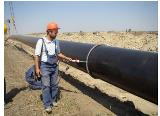
Fig.2.II. Verificarea izolației înaintea lansării conductei în șanț
