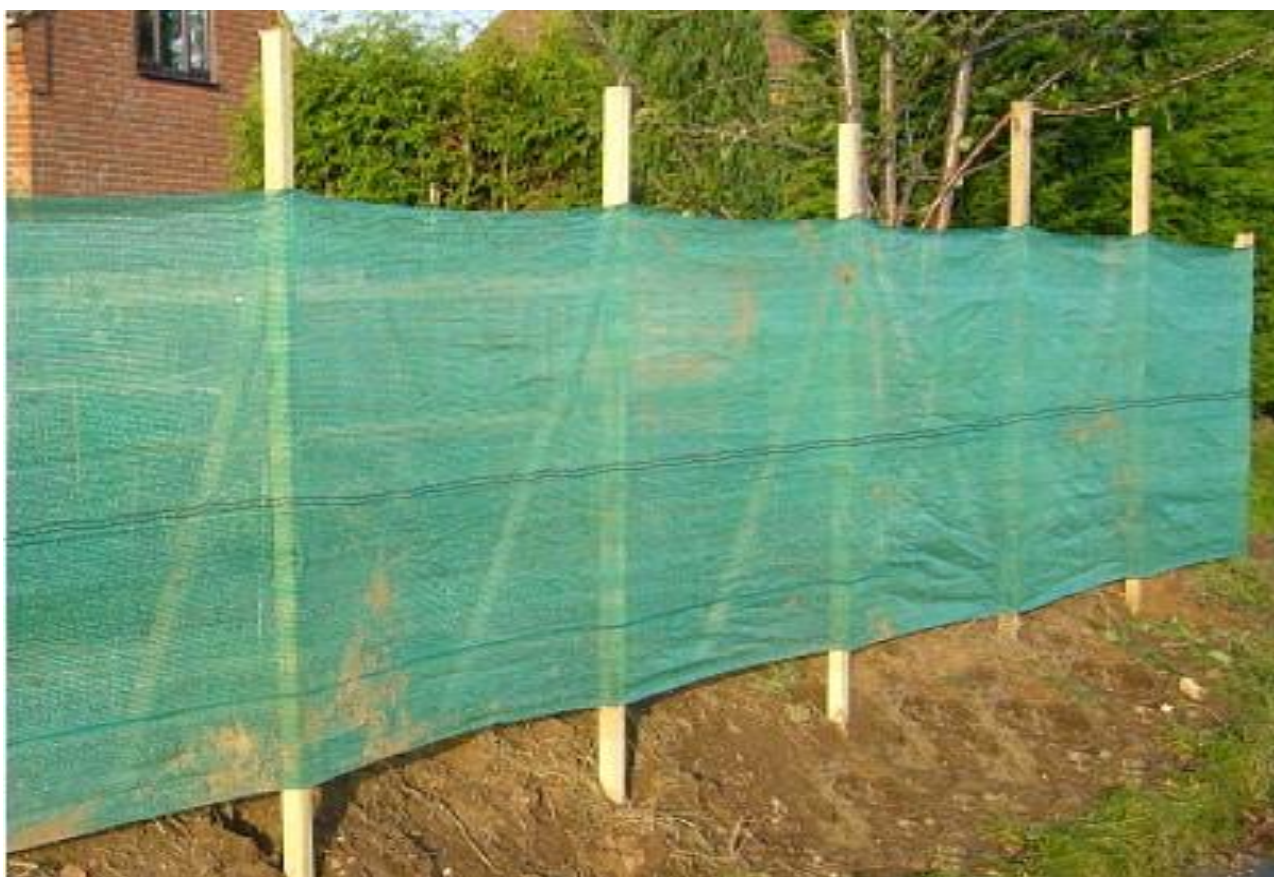
Fig.4.VII. Model de structură de delimitare a zonelor de șantier cu ajutorul materialelor textile (mesh) ce prezintă avantaje multiple (ecranare vizuală, limitare a poluării cu praf, limitare a accesului neautorizat, etc.)
