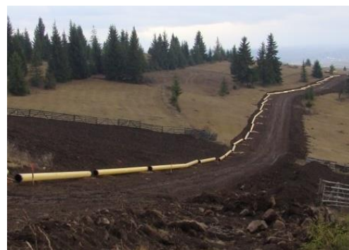
Fig.2.I. Segmente de țevă înșirate în lungul șanțului
