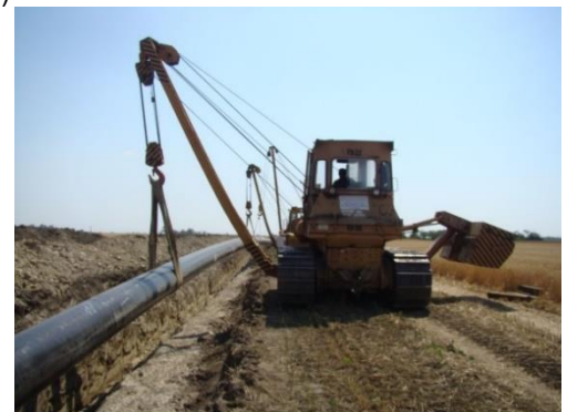
Fig.2.III. Coloană de lansatoare de țevă în acțiune
