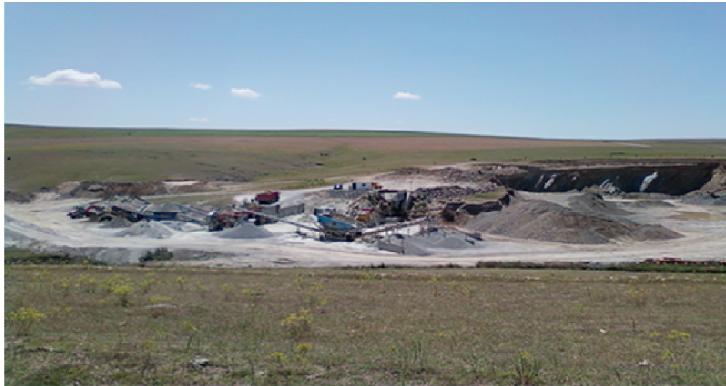
Fig. 2. Platforma instalatiei de prelucrare (concasare- sortare)
