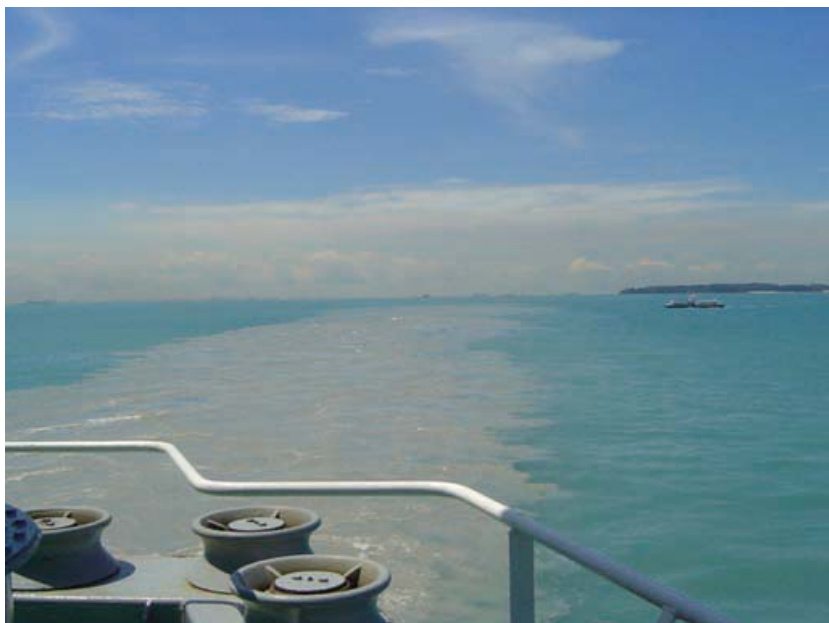
Pana de turbiditate generata de o draga de tip TSHD
