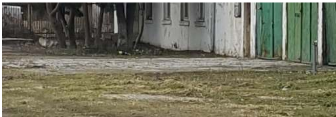
Foto: Platforma betonata in fata cladirii C3
