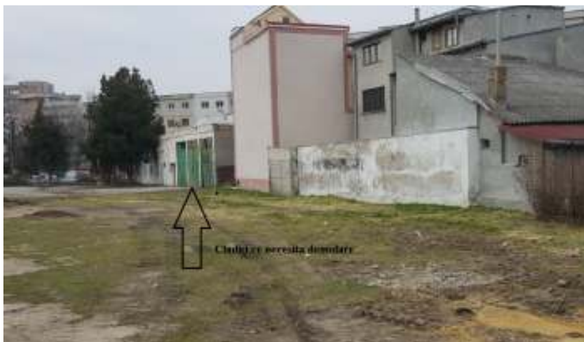
Foto : Cladiri ce necesita demolare
