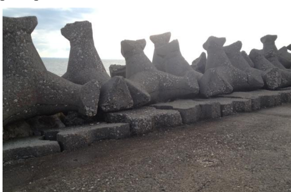
Fig. 3 Manta de blocuri de piatră de 1-3t/buc și carapace din stabilopozi de 4,5t/buc înclinați înspre larg, pe suport de blocuri evidate de 4,1t/buc cu deplasări pe verticală a acestora. ( foto : D.Craciun)
