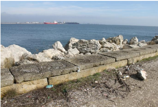
Fig. 10 Coronament pe Digul de Sud , Port Midia
