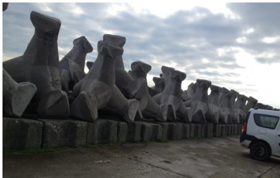
Fig. 2 Manta de blocuri de piatră de 1-3t/buc și carapace din stabilopozi noi de 4,5t/buc deplasată, pe suport de blocuri evidate de 4,1t/buc
