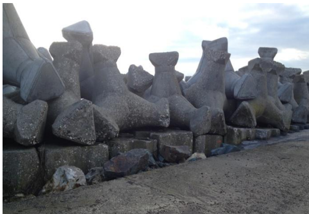
Fig. 4 Manta de blocuri de piatră de 1-3t/buc și carapace din stabilopozi de 4,5t/buc înclinați înspre larg, cu completări de stabilopozi noi de 4,5t/buc pe suport de blocuri evitate de 4,1t/buc ce prezintă deplasări atât pe orizontală cât și pe verticală( foto : D.Craciun)
