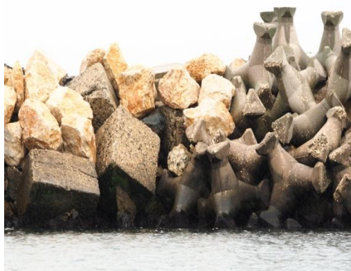
Fig. 6 Manta de blocuri de piatră de 1-3t/buc și carapace din stabilopozi de 4,5t/buc înclinați înspre larg, pe suport de blocuri de piatră ce prezintă deplasări atât pe orizontală cât și pe verticală a acestora. ( foto : D.Craciun)
