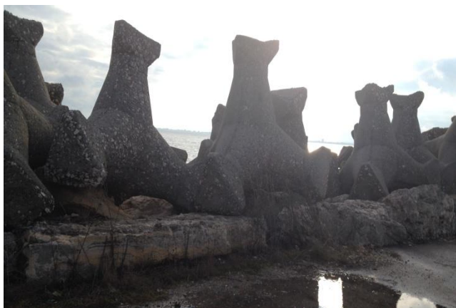
Fig. 2 Manta de blocuri de piatră de 1-3t/buc și carapace din stabilopozi de 4,5t/buc deplasată, pe suport de blocuri de piatră cu deplasări pe verticală a acestora ( foto : D.Craciun)
