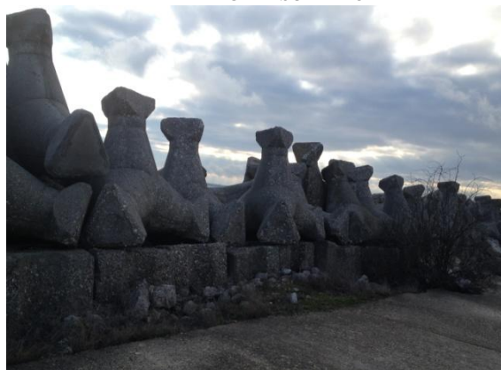
Fig. 4 Manta de blocuri de piatră de 1-3t/buc și carapace din stabilopozi de 4,5t/buc înclinați înspre larg, cu completări de stabilopozi noi de 4,5t/buc pe suport de blocuri evitate de 4,1t/buc ce prezintă deplasări atât pe orizontală cât și pe verticală( foto : D.Craciun)
