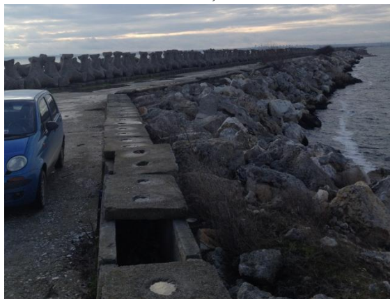
Fig. 7 Manta din blocuri de piatră naturală cu canal de instalații de 34x30cm dimensiuni interioare în secțiune transversală( foto : D.Craciun)
