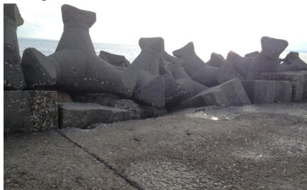
Fig. 3 Manta de blocuri de piatră de 1-3t/buc și carapace din stabilopozi de 4,5t/buc înclinați înspre larg, pe suport de blocuri evidate de 4,1t/buc cu deplasări pe verticală a acestora. ( foto : D.Craciun)
