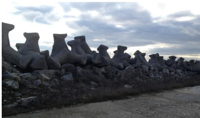
Fig. 5 Manta de blocuri de piatră de 1-3t/buc și carapace din stabilopozi de 4,5t/buc înclinați înspre larg, pe suport de blocuri de piatră ce prezintă deplasări atât pe orizontală cât și pe verticală a acestora. ( foto : D.Craciun)
