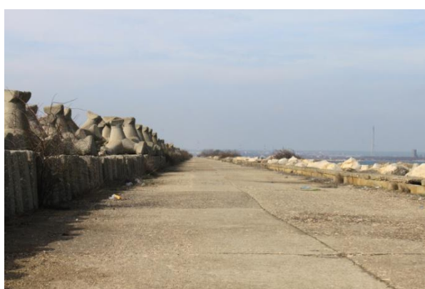
Fig. 10 Coronament pe Digul de Sud , Port Midia
