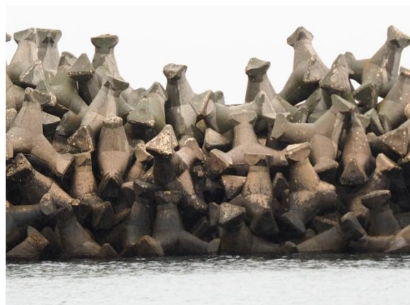
Fig. 2 Manta de blocuri de piatră de 1-3t/buc și carapace din stabilopozi de 4,5t/buc deplasată, pe suport de blocuri de piatră cu deplasări pe verticală a acestora ( foto : D.Craciun)
