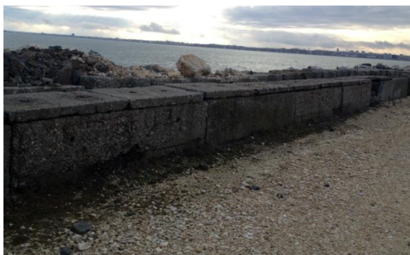
Fig. 6 Manta de blocuri de piatră de 1-3t/buc și carapace din stabilopozi de 4,5t/buc înclinați înspre larg, pe suport de blocuri de piatră ce prezintă deplasări atât pe orizontală cât și pe verticală a acestora. ( foto : D.Craciun)
