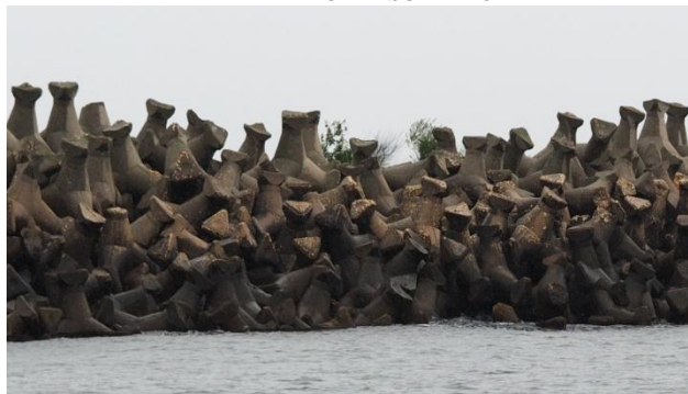
Fig. 2 Manta de blocuri de piatră de 1-3t/buc și carapace din stabilopozi noi de 4,5t/buc deplasată, pe suport de blocuri evidate de 4,1t/buc
