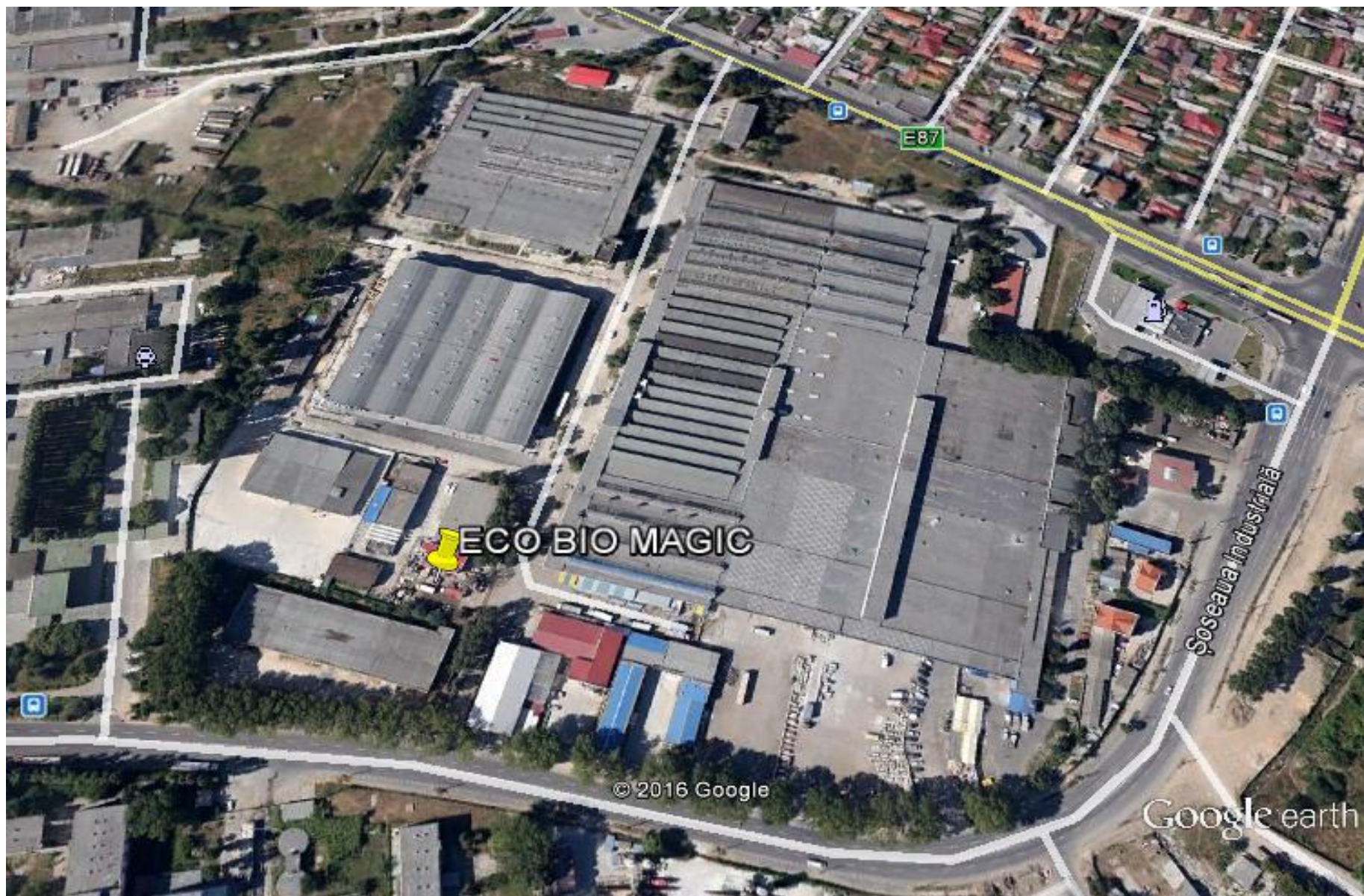
Foto 1. Amplasamentul instalatiei in raport cu vecinatatile
