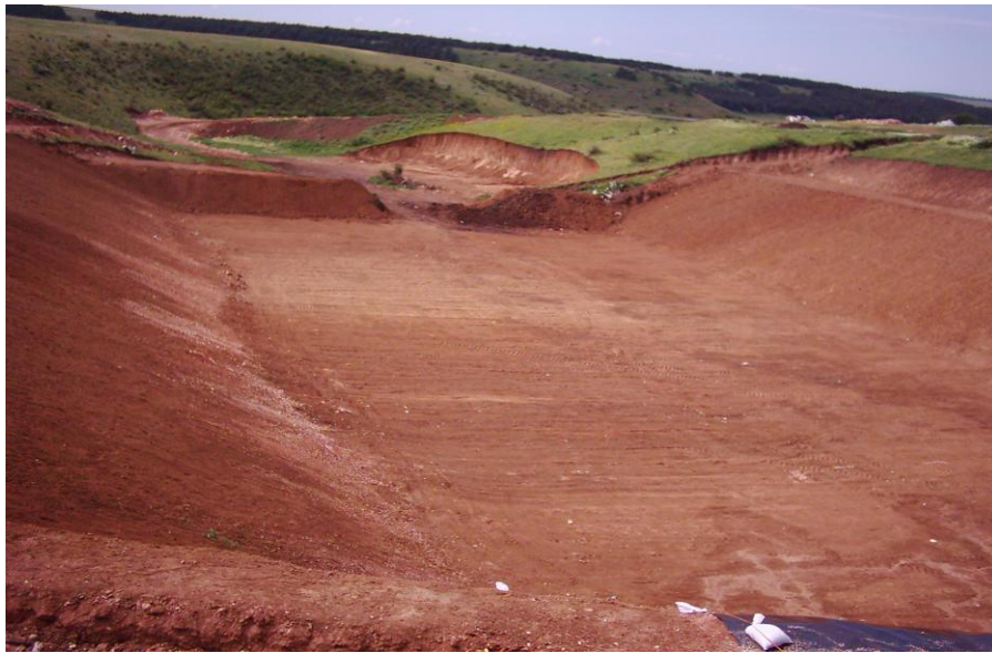
Foto 2. Amenajarea cuvetei celulei de depozitare
