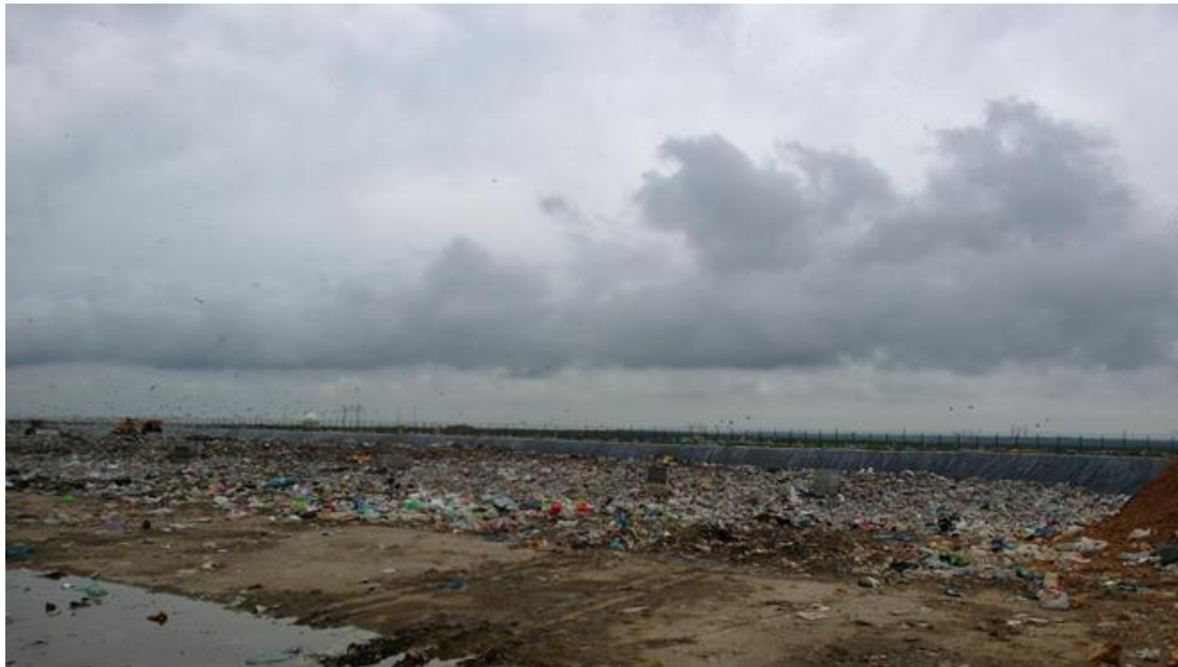
Fig.5 - Platforma pentru descarcarea deseurilor(latura sud-vestica) – celula VI
