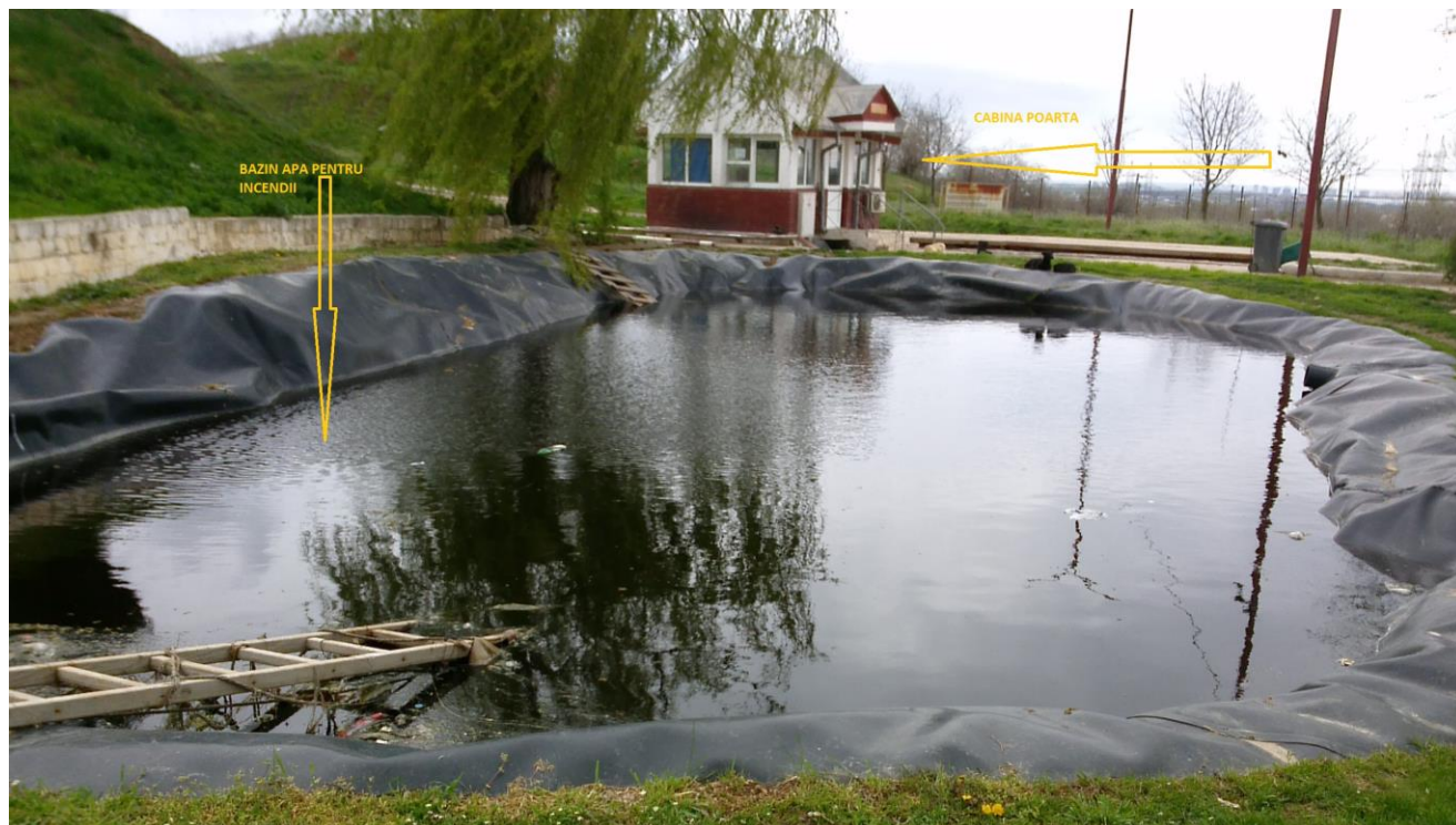
Fig. 6 - Bazin rezerva apa pentru incendii
