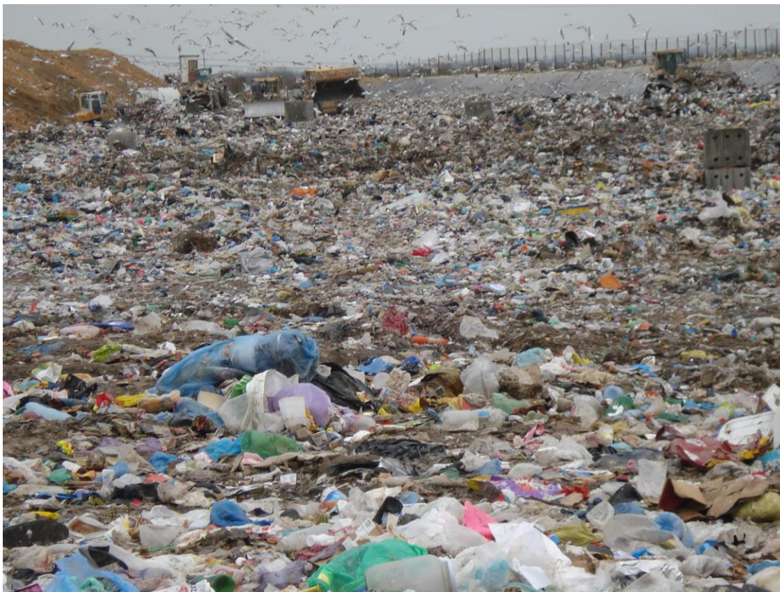
Fig.14 - Nivelare deseuri in celula VI cu ajutorul buldozerelor cu lama
