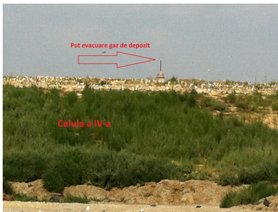
Fig.20 - Put pentru evacuarea gazului de depozit
