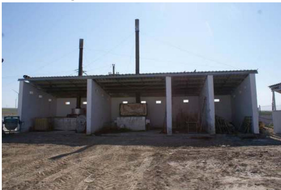
Aspect al incineratoarelor
