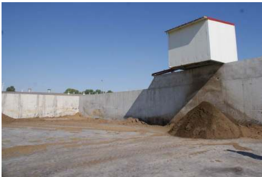
Aspect al platformei betonate pentru stocarea temporara a dejectiilor solide
