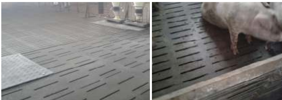
Aspect al pardoselii betonate cu gratare
