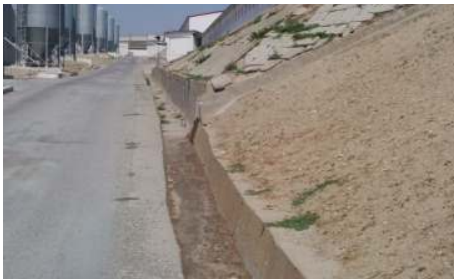
Aspect al rigolelor placate cu beton
