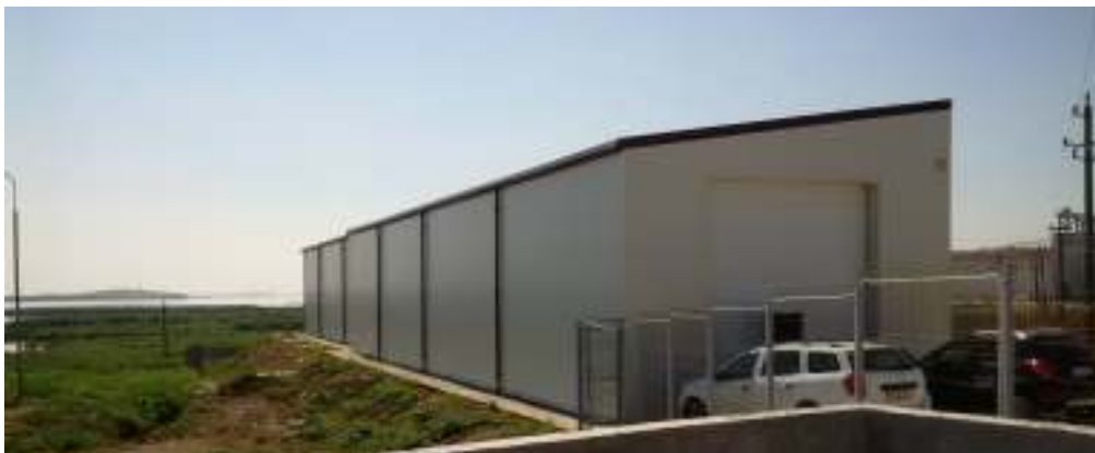
Cladire – Spalatorie camioane
