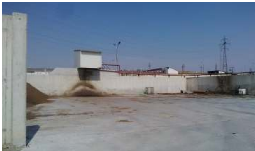
Aspect al platformei betonate pentru stocarea temporara a dejectiilor solide
