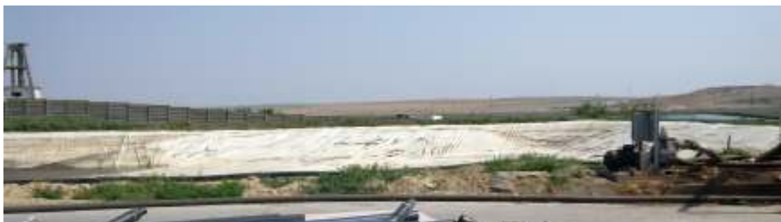
Evidentierea membranei geotextile din interiorul lagunei
