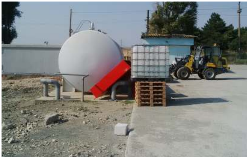
Platforma betonata si rezervor motorina
