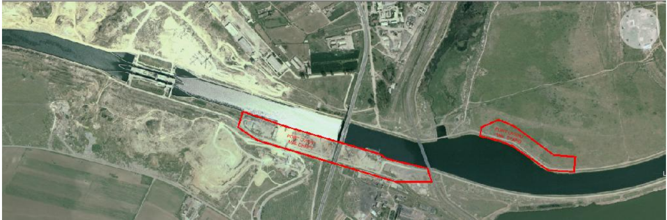
Figura nr. 4.1 - Amplasamentul lucrarilor
