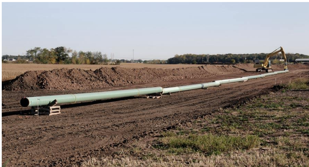
Foto 6: Formarea șirului de țevi
