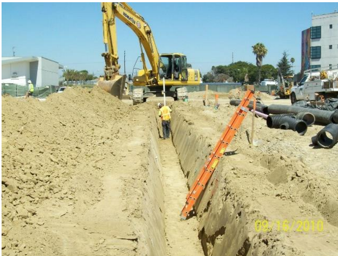
Foto 3: Săparea șanțului cu echipament mecanizat: excavator cu cupă normală sau profilată
