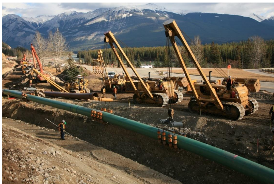
Foto 7: Lansarea conductei în șanț deschis cu ajutorul lansatoarelor de conducte tip TL4
