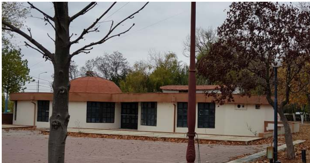
Foto: Aspect cladire existenta pe amplasament
