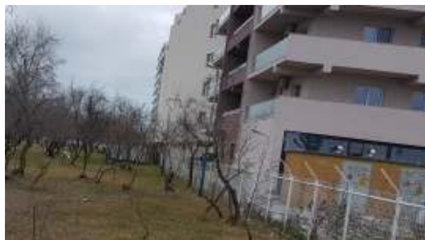
Foto: Imprejmuire si iluminare a incintei pe latura de sud
