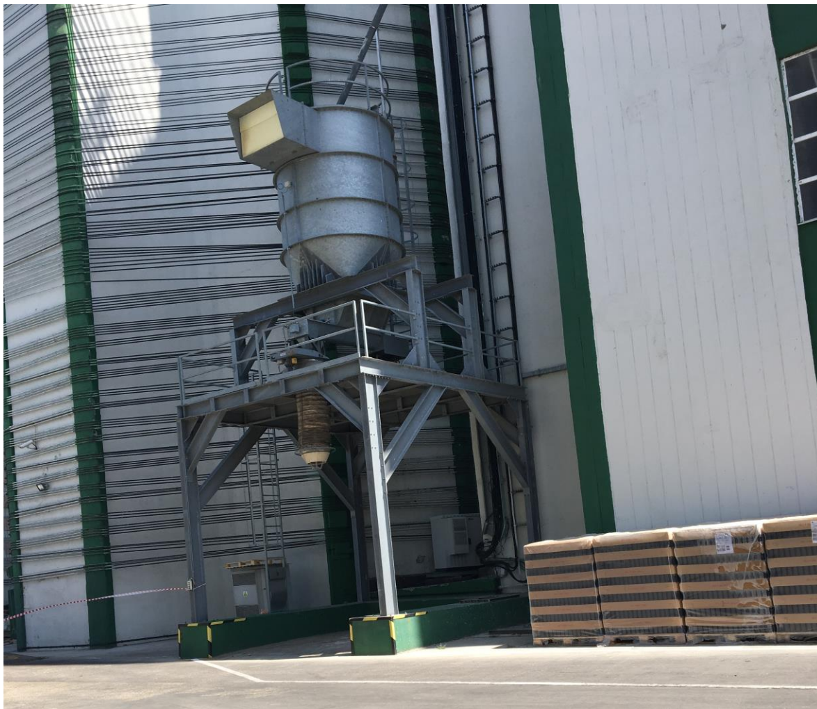
Foto 13. Instalatia de incarcare a plevii in autospeciale
