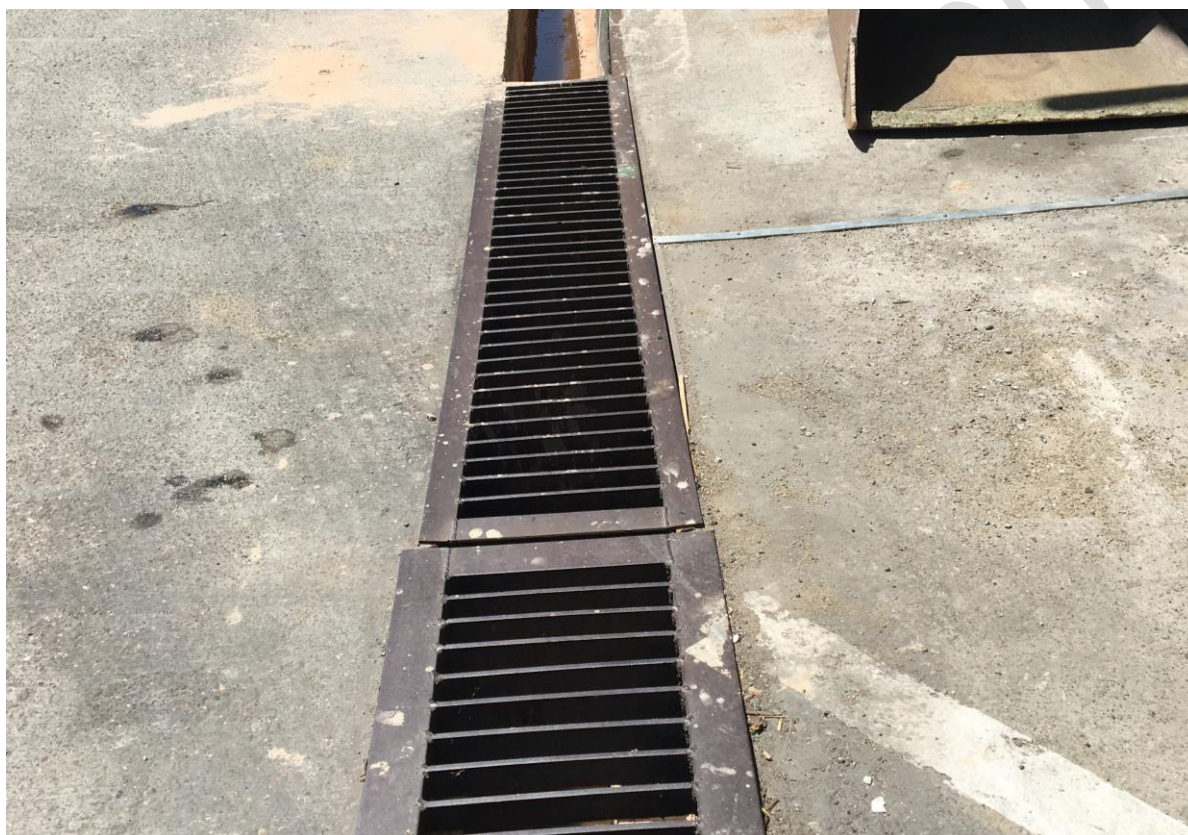
Foto 22. Rigola ape pluviale
