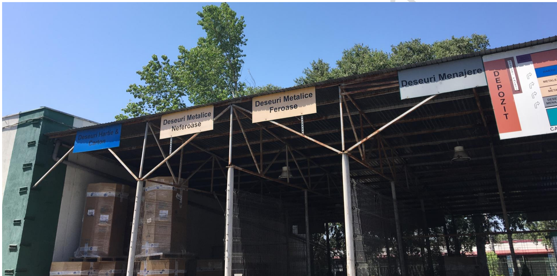
Foto 26. Spatiu acoperit, betonat, special amenajat pentru colectarea si stocarea temporara a deseurilor generate
