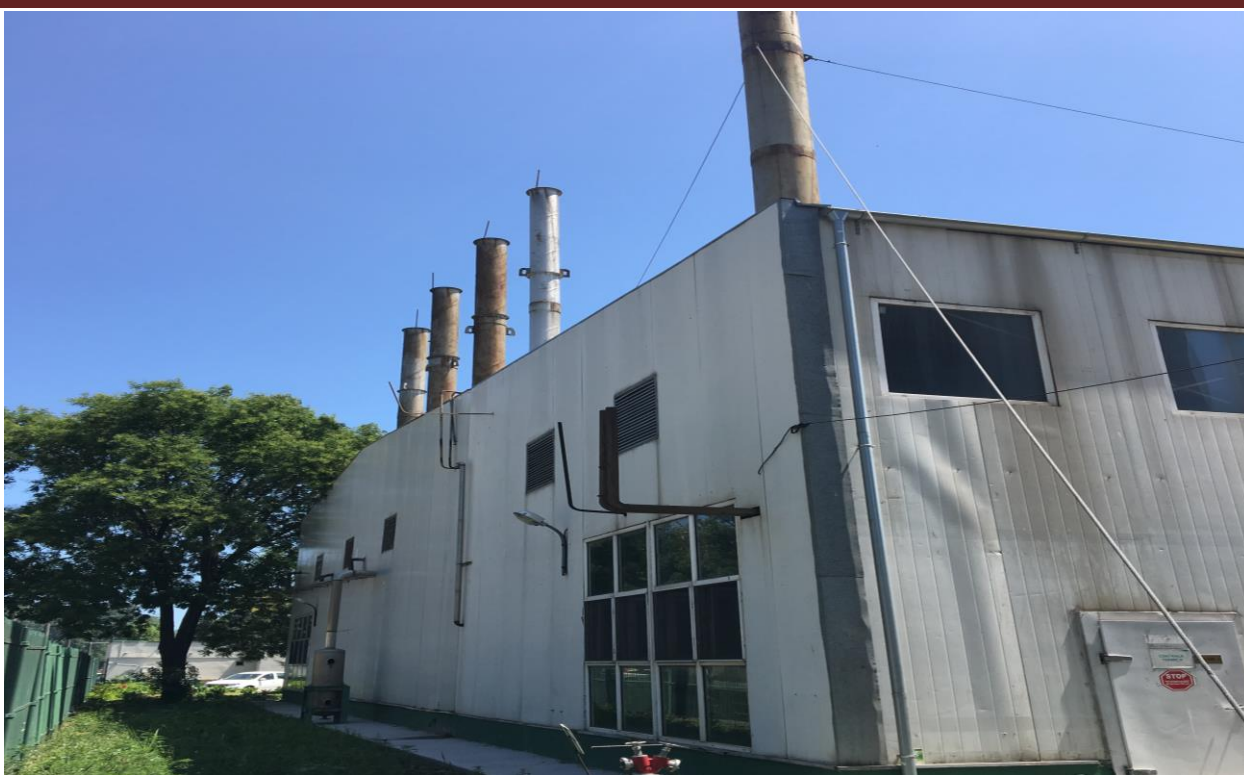
Foto 8. Centrala termica – cosurile de dispersie
