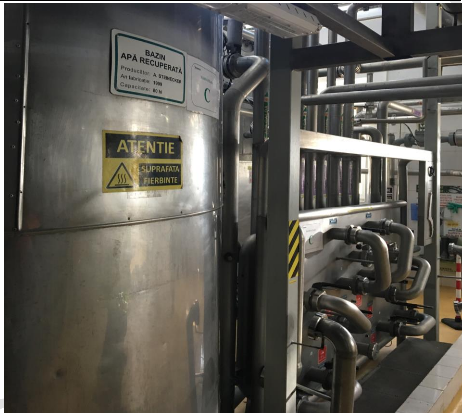
Foto 19. Bazin din sistemul de recuperare a apei
