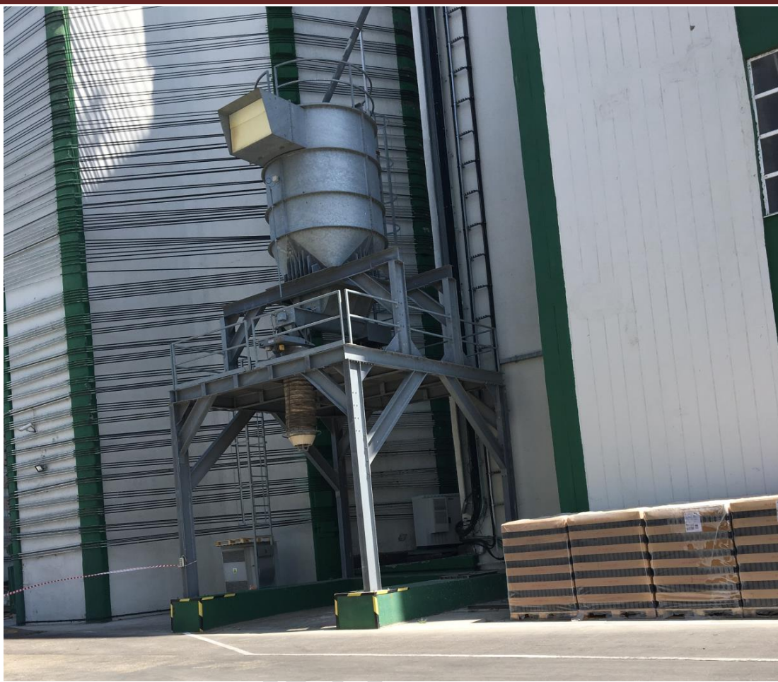
Foto 3. Instalatia de incarcare a plevei in autospeciale
