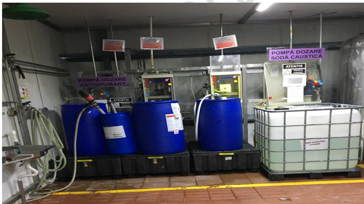
Foto 10. Formare solutii pentru CIP
