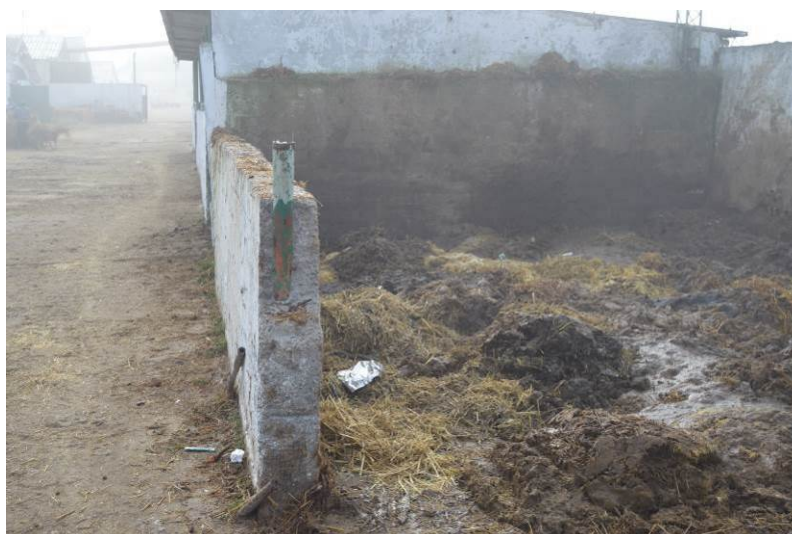
Platforma depozitare gunoi de grajd
