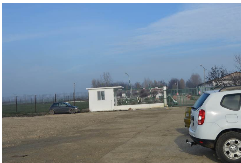
Asigurarea protecției accesului în ferma
