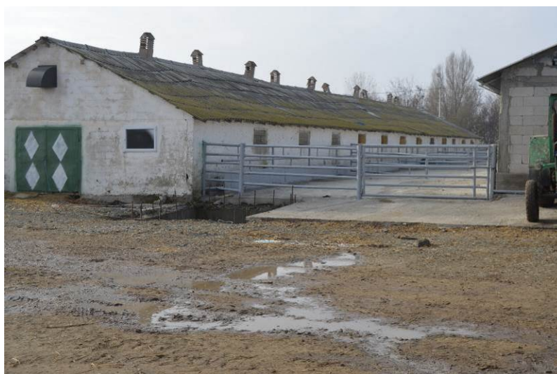
Bazin vidanjabil in constructie
