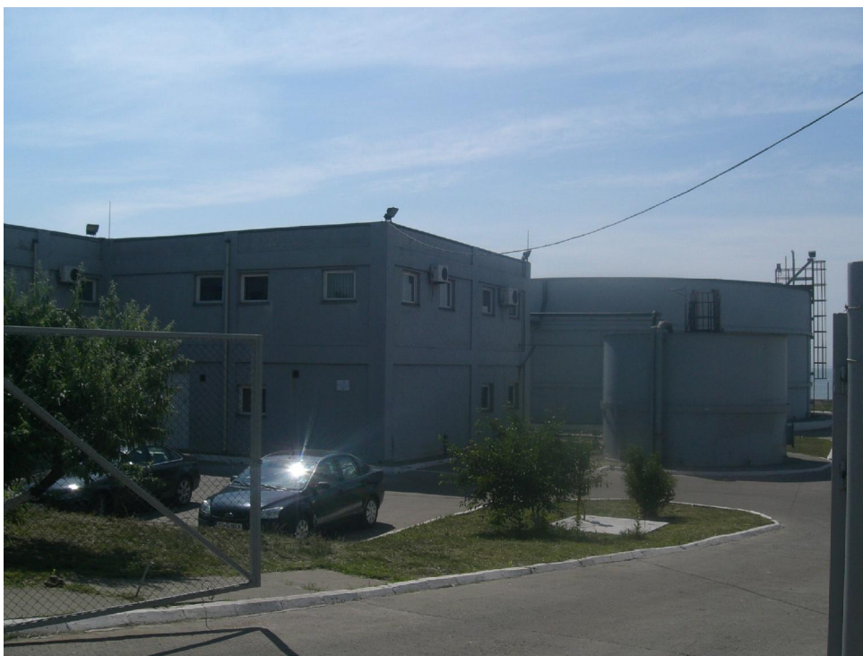
Figura 4.7-2: Stația de tratare apă uzată de la dana 79
