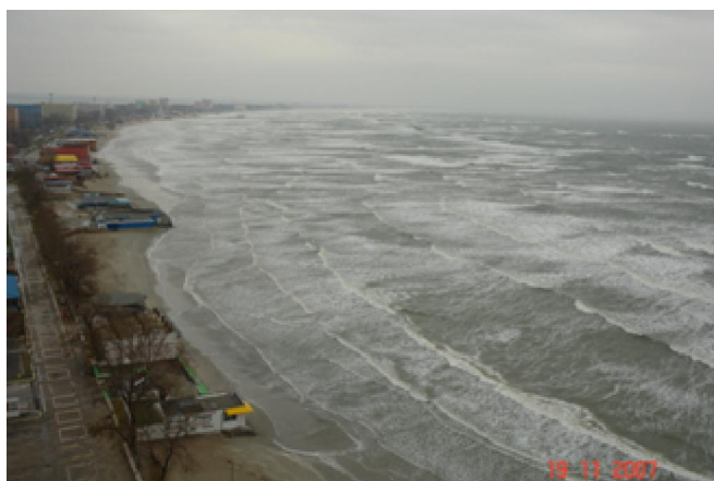
Fig 7.5-1- Avansarea valului pe taluz în sectorul protejat sudic al plajei Mamaia pe timp de furtună : cca 20 m în fața parapetului aleei de promenadă, în medie 50-60m pe taluzul plajei de la linia apei
