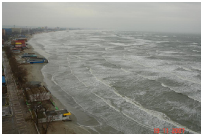
Fig 7.5-1- Avansarea valului pe taluz în sectorul protejat sudic al plajei Mamaia pe timp de furtună : cca 20 m în fața parapetului aleii de promenadă, în medie 50-60m pe taluzul plajei de la linia apei
