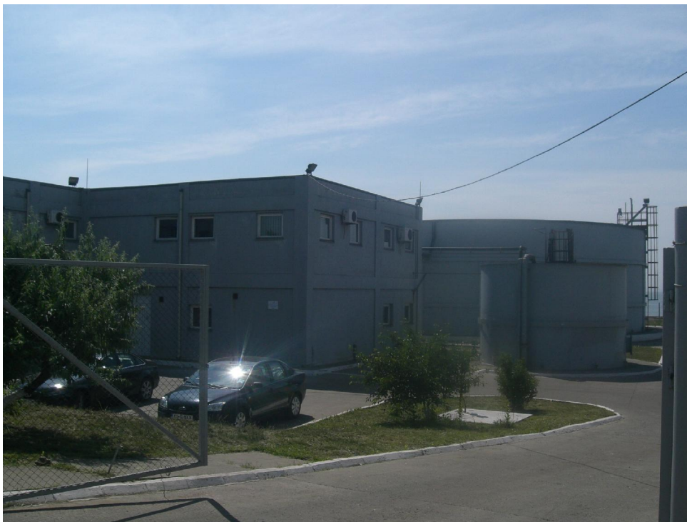
Figura 4.7-2: Stația de tratare apă uzată de la dana 79
