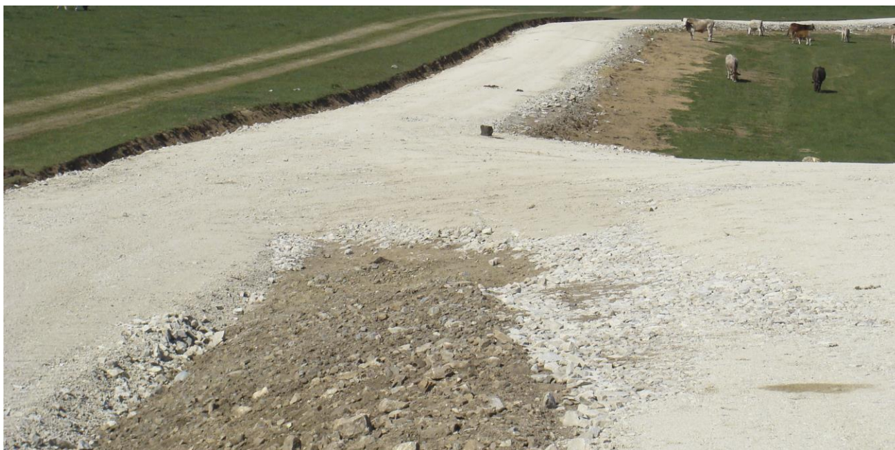
Figura 36. Aspect al unui drum de pământ consolidat cu anrocamente din calcar (zurai)
