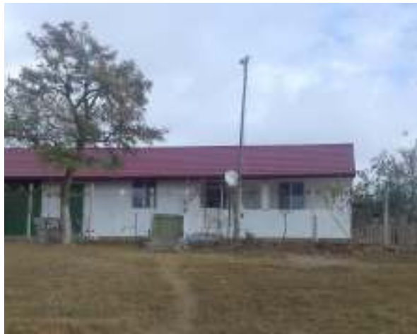
Aspect al constructiei existente
