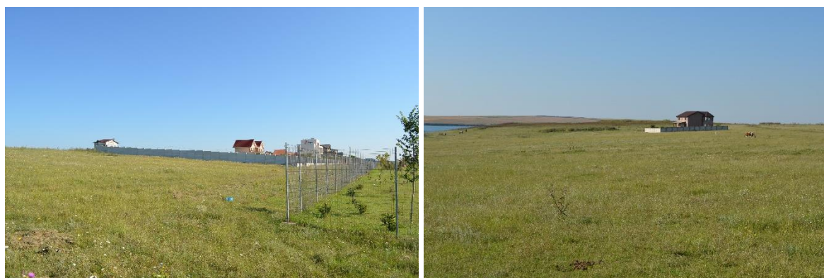
Fig. 12 Constructii in zona pajistilor stepice din cadrul ROSPA0061 Lacul Techirghiol (zona 2)
