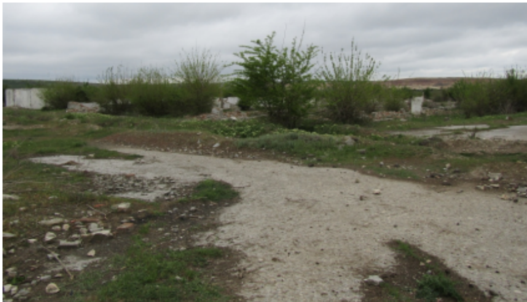
Foto: Platforma betonata in zona centrala a amplasamentului si alte structuri de beton partial demolate
