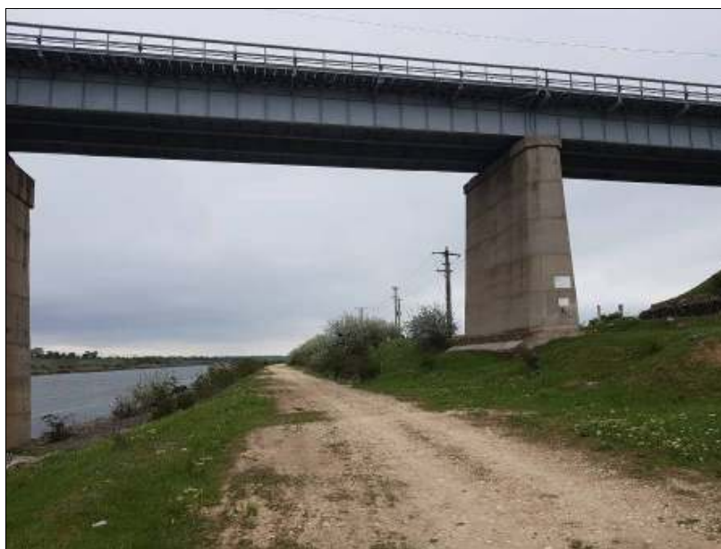
Foto: Drum acces in zona de nord a obiectivului
