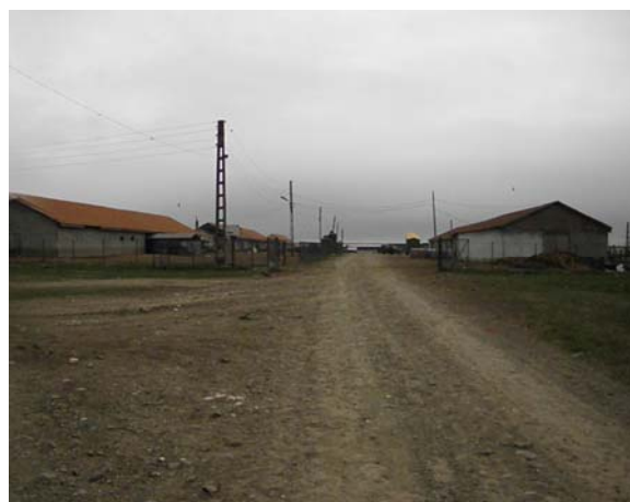
Foto nr. 1. Drumuri acces si retele electrice
