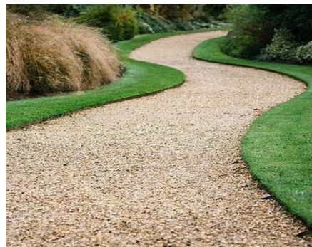
Fig. 12 Alei din pietris stabilizat simplu cu un liant poliuretanic-rasina sintetica netoxica
