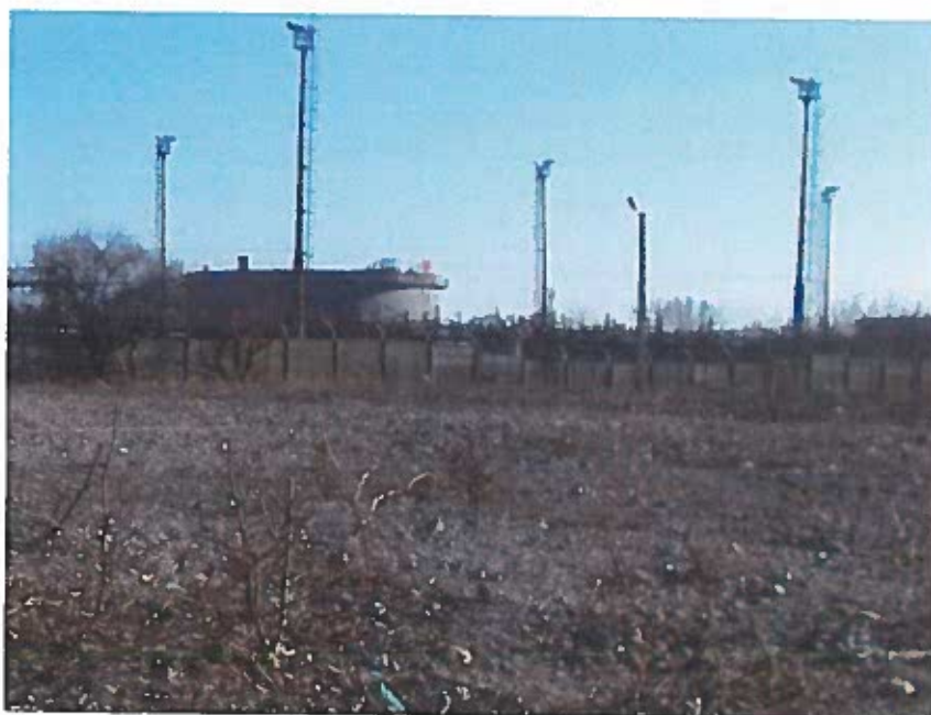
Foto 2 – Zona estica a amplasamentului
