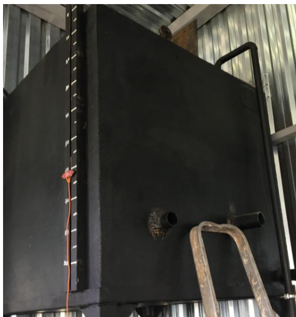
Foto 26. Rezervor CLU – combustibil pentru CT abur tehnologic
