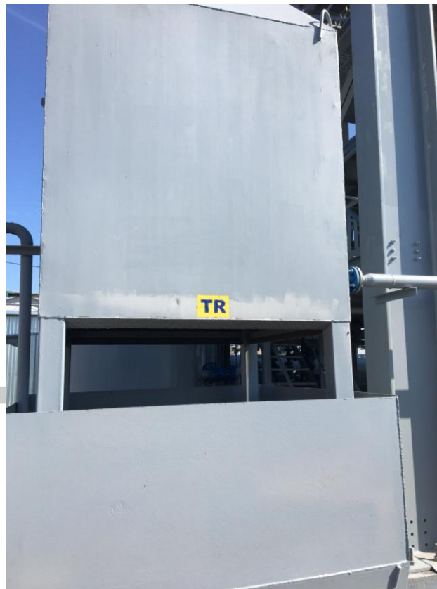
Foto 11. Turn racire pentru apa recirculata in instalatie
