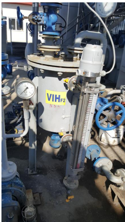
Foto 20. Priza laterala VIH F2 a coloanei de distilare pentru ulei fractia II
