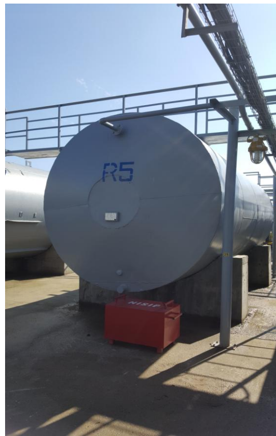
Foto 19. Rezervorul R5 pentru depozitare ulei Fractia I
