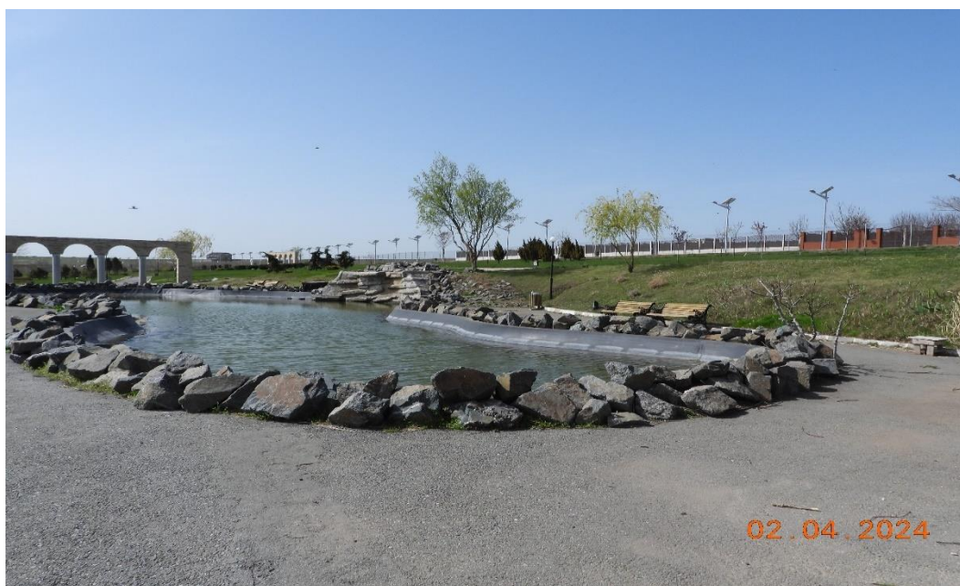
Figura 16 - Tronsonul de nord al Grădinii Botanice (vedere spre sud)
