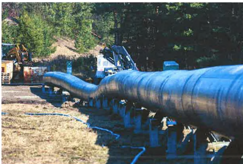
Imagine 3. Conducta produs montată pe role
