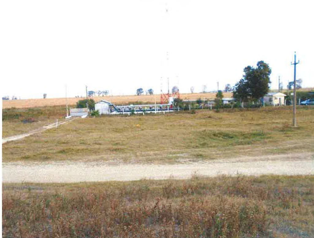
Imagine 10. Vedere de pe digul de apărare împotriva inundațiilor de pe malul drept al brațului Borcea spre punctul de lucru C3
