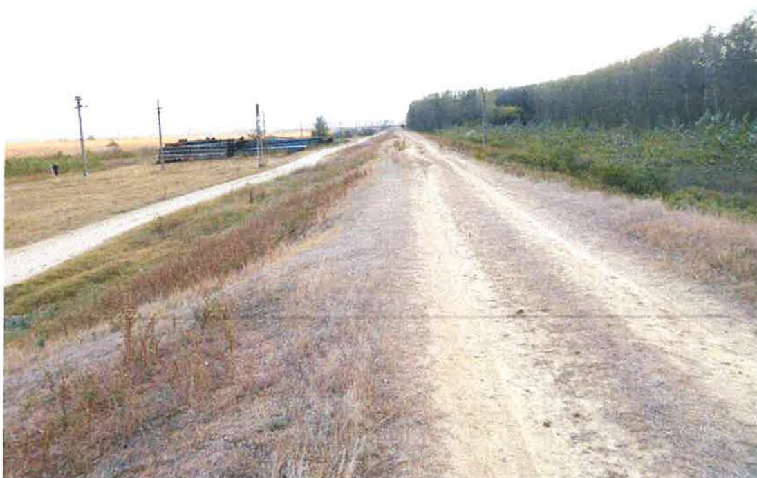
Imagine 11. Vedere de pe digul de apărare împotriva inundațiilor de pe malul drept al brațului Borcea spre amonte – Autostrada A2
