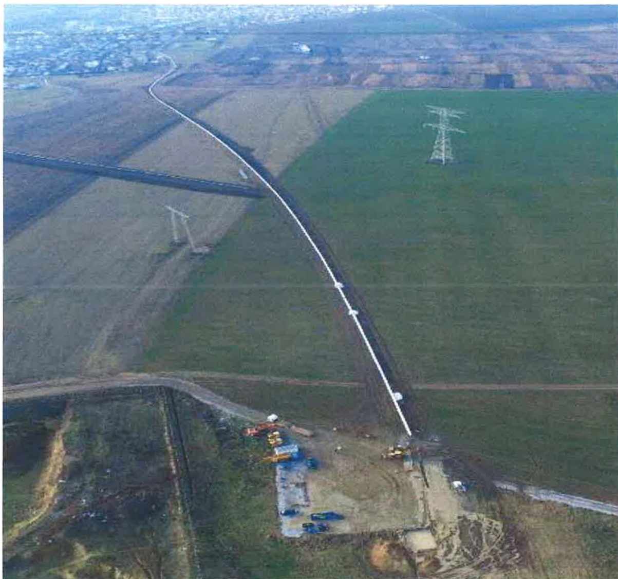
Imagine 5. Poziționare conductă înainte de tragere
