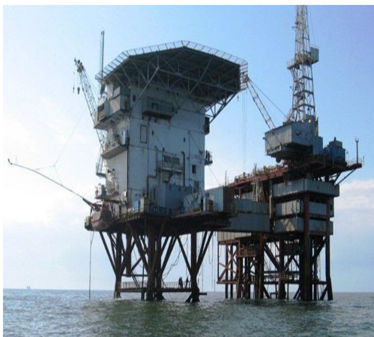
Figura nr. 4. Platforma fixă suport sonde nr. 7 (PFSS 7).
