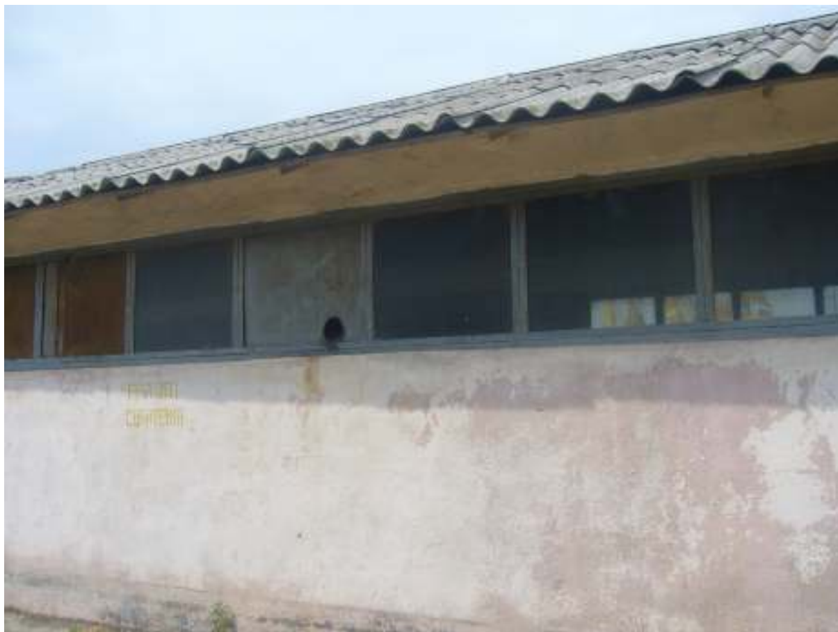
Foto 5 : Depozit materiale, cu acoperis din azbociment
