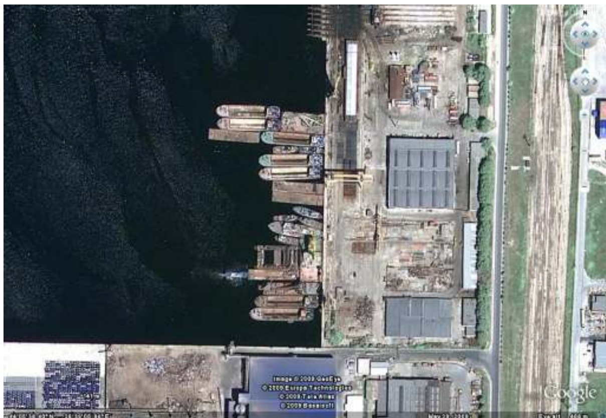
Fig.nr. 5 : nave si utilaje ancorate in zona de cheu
