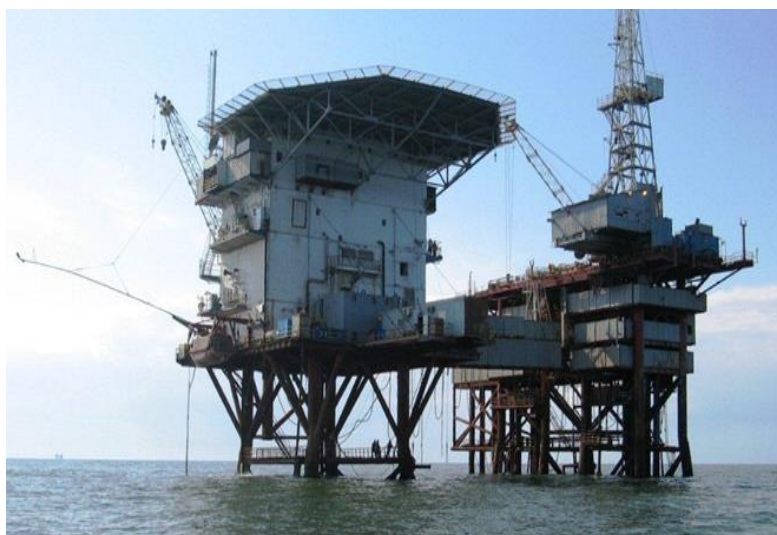
Figura nr. 1.2.a. Platforma fixă suport sonde nr. 7 (PFSS 7)
