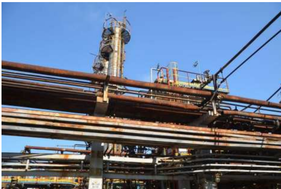
Foto 3 – Estacada tehnologică (nu va fi demolată)
