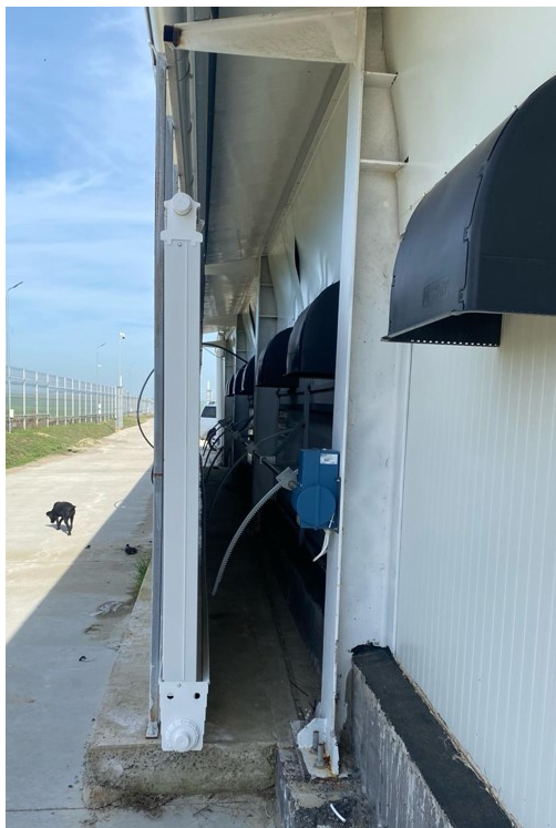
Fig.12 – Sistem de racire cu faguri celulozici (PAD cooling)
