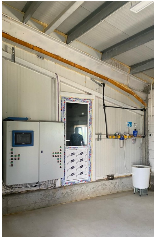
Fig. 7 – Sistem de comanda microclimat
