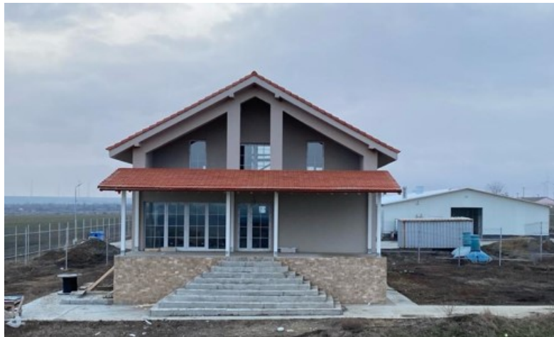
Fig.13 – Sediu administrativ/Filtru sanitar
