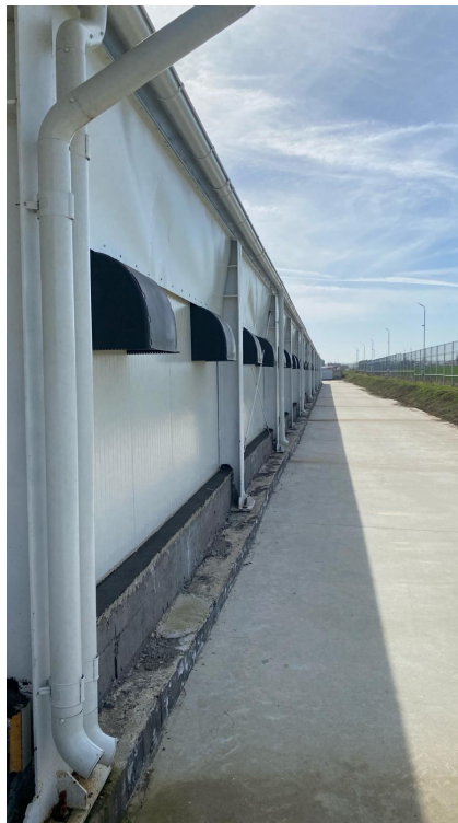
Fig.10 – Sistem de admisie cu deflector
