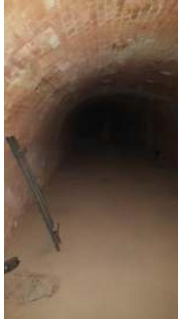
Este format din doua ramuri paralele, unite la capete cu cate un canal circular de legatura cu aceeasi sectiune ca ramurile principale. Canalul de ardere este impartit conventional in camere (prin camera se intlege o portiune din canalul de ardere), prevazute cu usa de incarcare si canalul de fum de legatura pentru evacuarea gazelor arse in canalul colector.
