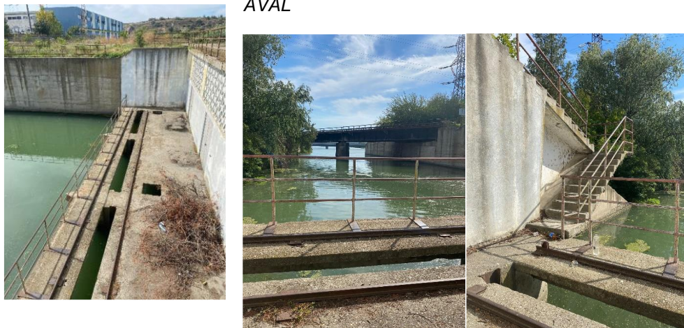
Foto III.3 ÷ III.5 - IMAGINI AMPLASAMENT – VEDERE ÎN AVAL
