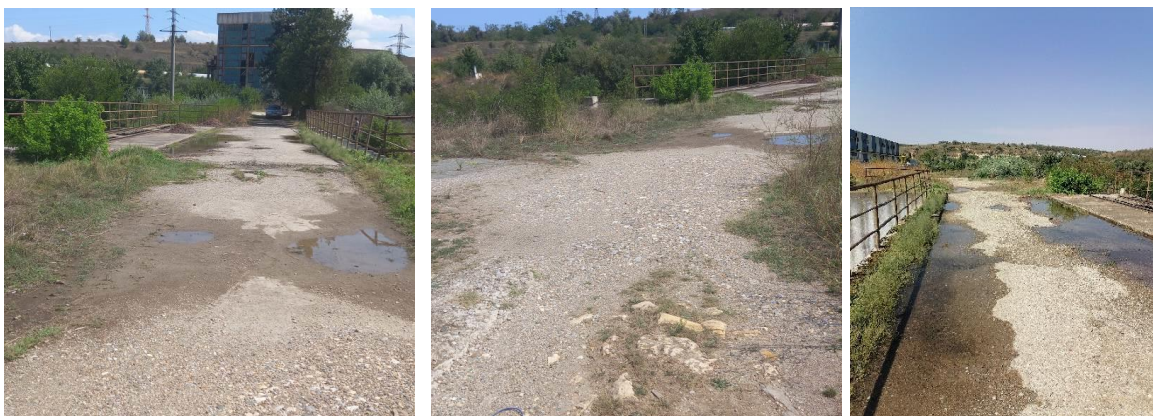
Foto III.10 , Foto III.11 – Drumul de acces la drumul de coronament de pe malul drept cu impietruire și gropi, fara panta de scurgere a apelor și Foto III.12 - Vedere dinspre drumul de pe baraj catre malul drept
