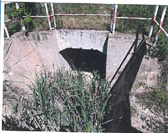
Podeț existent km 4+071
