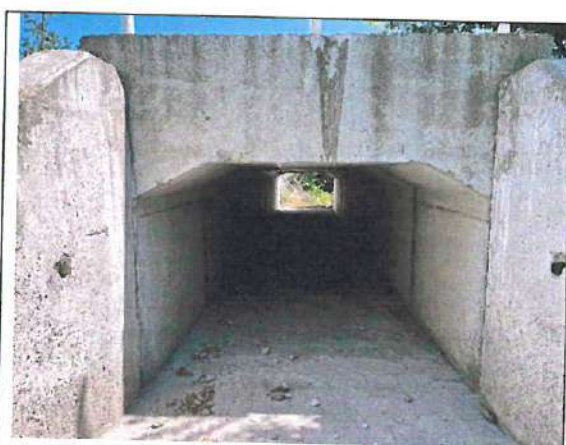
Podeț existent km 1+890
