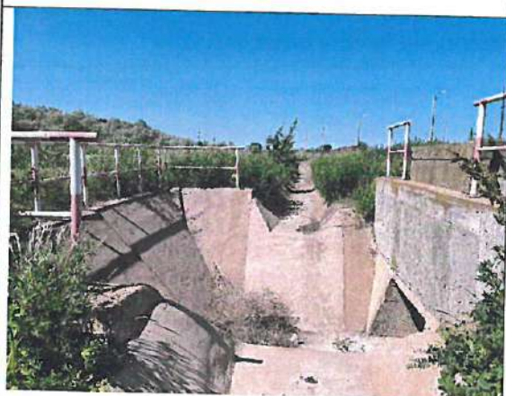
Podeț existent km 3+672
