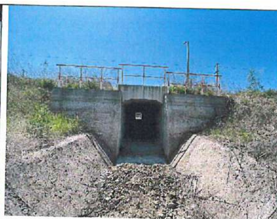
Podeț existent km 3+294
