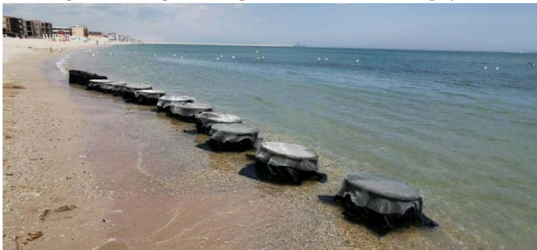
Aspect al cosurilor umplute anterior cu nisip uscat si umed din cadrul celulei de plaja ECnBS2
