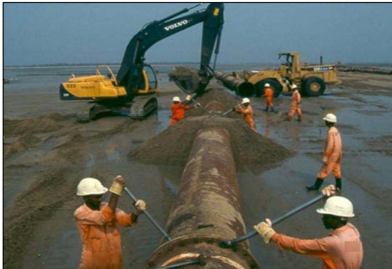
Instalarea unei conducte de innisipare. Exemplu
