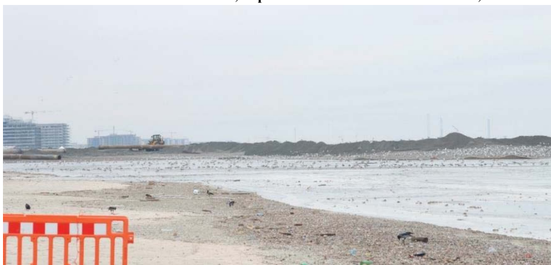
Pescarusi in zona lotului Mamaia, in perioada de constructie- 15.12 2020, Mamaia
