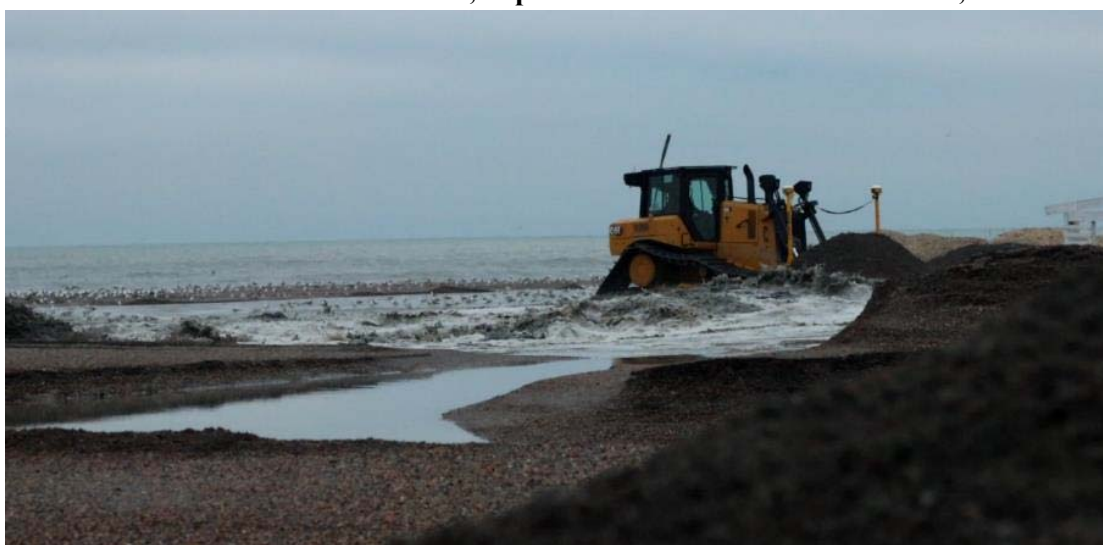
Pescarusi in zona lotului Mamaia, in perioada de constructie- 15.12 2020, Mamaia
