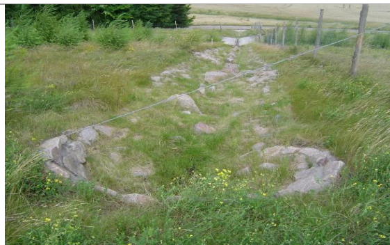
Plansa 1. Aplicații ale unor structuri de tipul rigolelor înierbate și a bazinelor temporare
