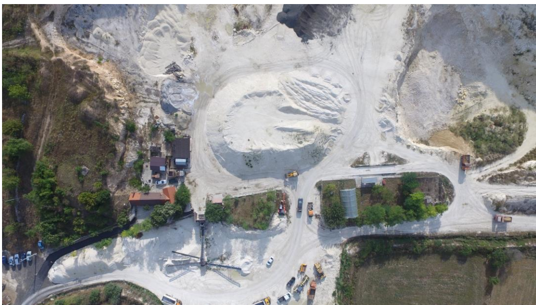
Figura 21. Imagine de ansamblu asupra vetrei de carieră la nivelul căreia se disting: zona organizării de șantier, stația de concasare/sortare, conurile de depozitare a sorturilor obținute, utilajele de lucru
