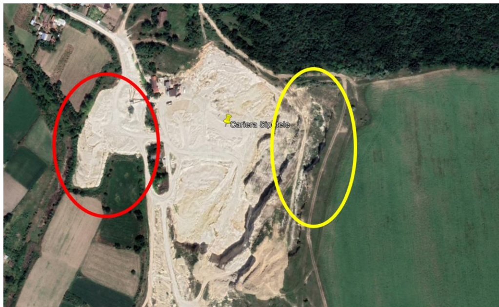
Figura 20. Perimetre ce se pretează la depozitarea sterilelor de carieră : cu roșu – delimitată zona de depozitare ce face obiectul unei chirii ; cu galben – trepte de la nivelul cărora zăcămintul a fost epuizat și pot face obiectul lucrărilor de corectare morfologică, depozitare a sterilelor de carieră și restaurare ecologică
