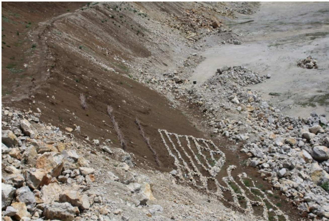
Figura 85. Cleionaje din material vegetal și anrocamente din piatră
