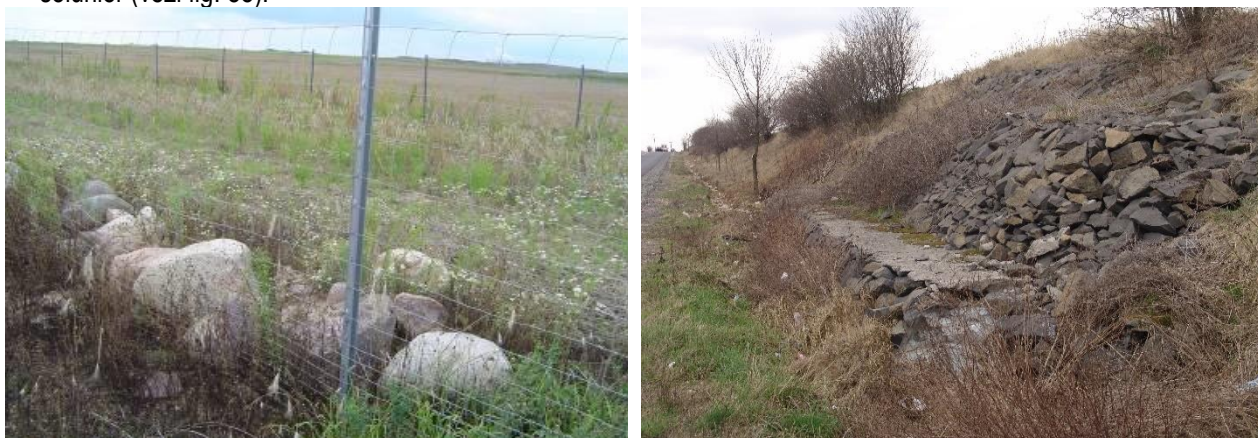
Figura 87. Utilizarea de bolovănișuri ca microhabitate este în măsură a oferi nișe suplimentare ecologice (stânga) și funcționând ca zone de drenaj a apelor de spălare ce contribuie substanțial la stabilizarea pantelor (dreapta).
