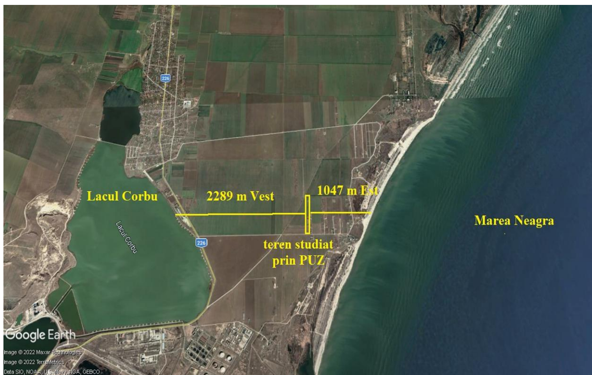
Fig. nr. 6 Distanțe de la cele mai apropiate corpuri de apă de suprafață la terenul studiat prin PUZ (conf. măsurătorilor Google Earth)
