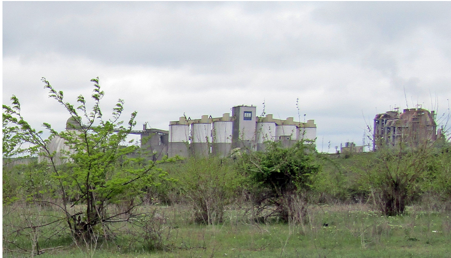
Foto: Vedere de ansamblu a fabricii de ciment din zona obiectivului
