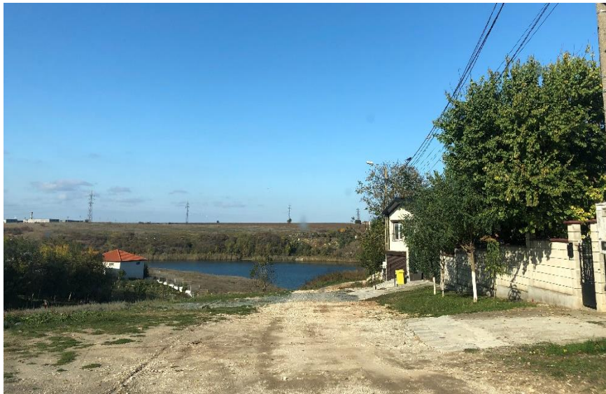
Fig. 4- Strada Caminului 1- situatia existenta
