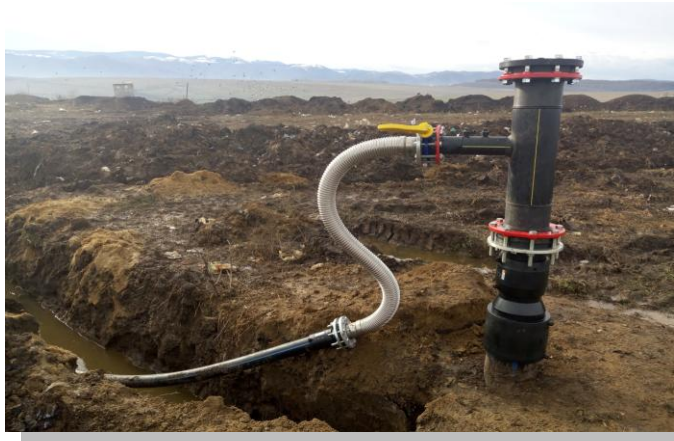
Figura 3 – Capul special de puț de gaz, record flexibil inox și conducta transportoare
